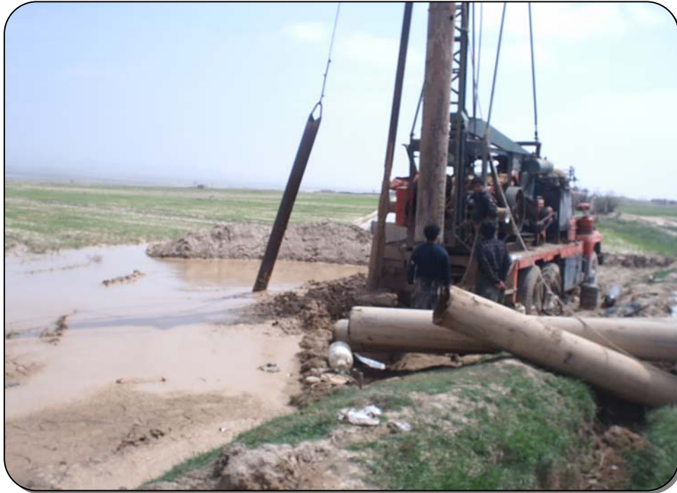
تصویر شماره ۹، عملیات حفاری چاه عمیق جدید روستا
