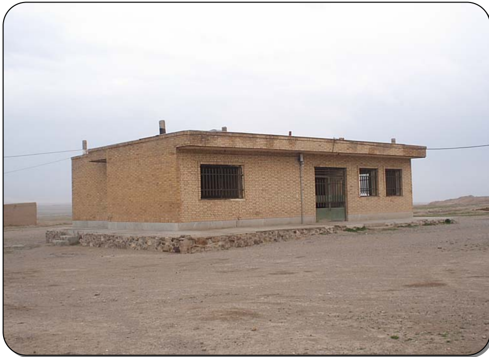
تصویر شماره ۷، دفتر مخابرات و پست که اکنون غیرفعال است
